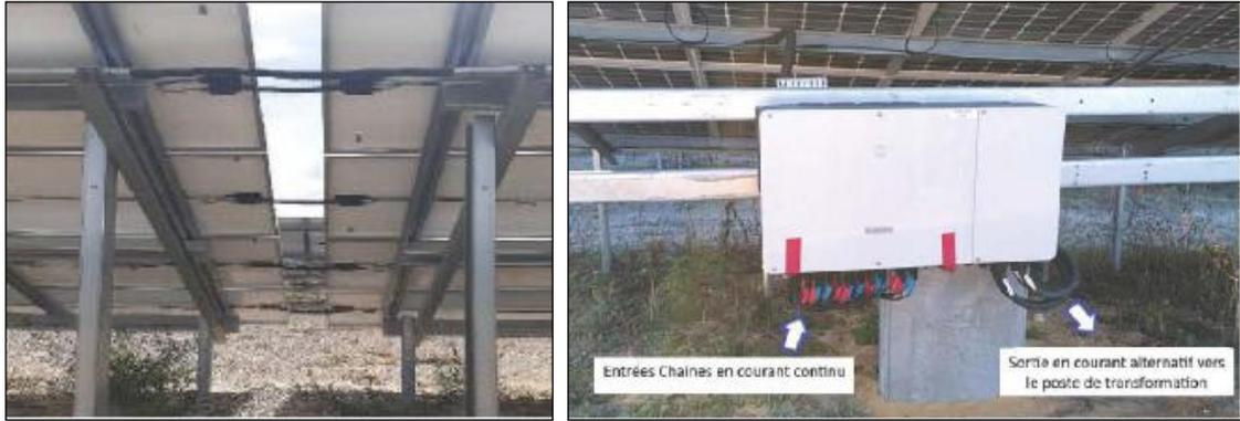
*Exemples de câblage sous modules et d'onduleur décentralisé*
